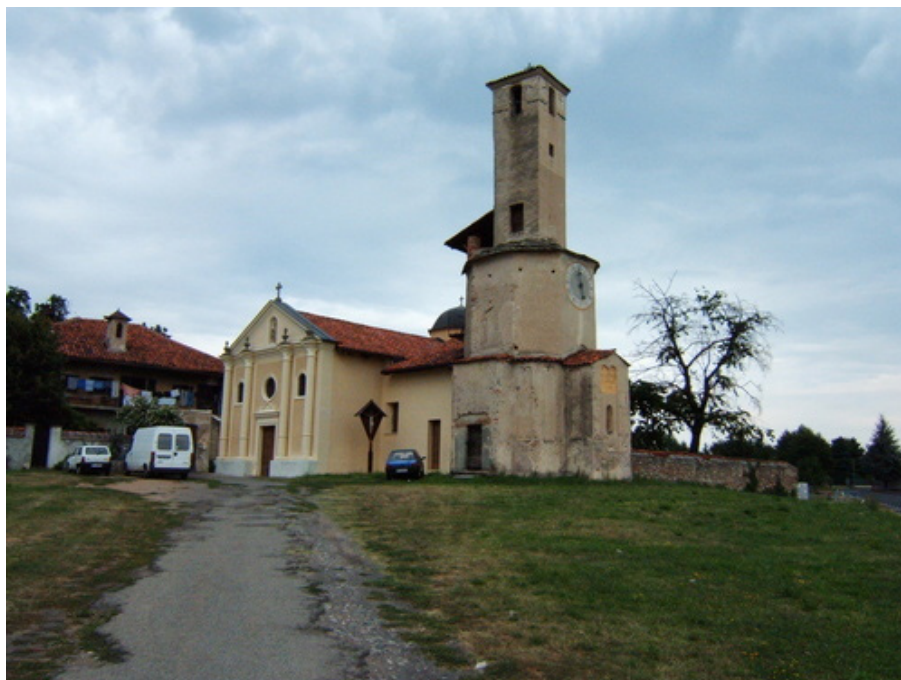
Figura 33 Chiesa Parrocchiale di San Ponzio con Battistero costruito a cavallo del X e XI secolo. Il campanile è stato aggiunto nel 1585.
