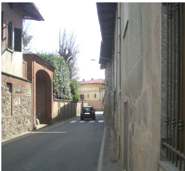
Figura 4 Tratto della SP n°36 che attraversa il centro storico.
